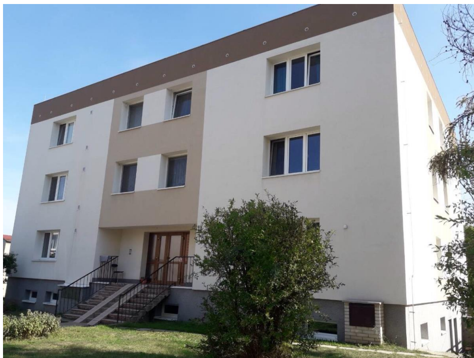
Bytové domy ve východní části městyse Zlonice.
