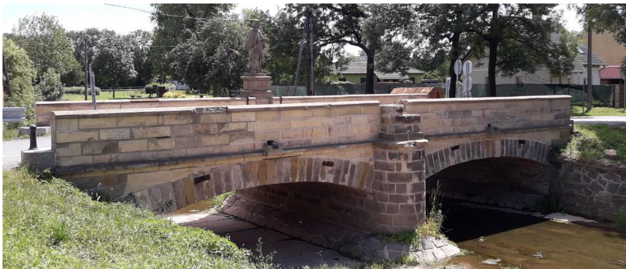
Silniční most se sochou sv. Jana Nepomuckého v centru obce Tmář, který je kulturní nemovitou památkou č.r. 29273/2-620.
