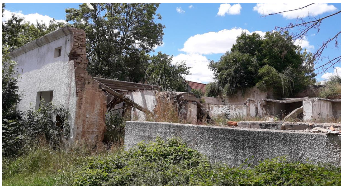
Zbořeniště obytného objektu navrženého na přestavbu v severní části obce Tmář.
