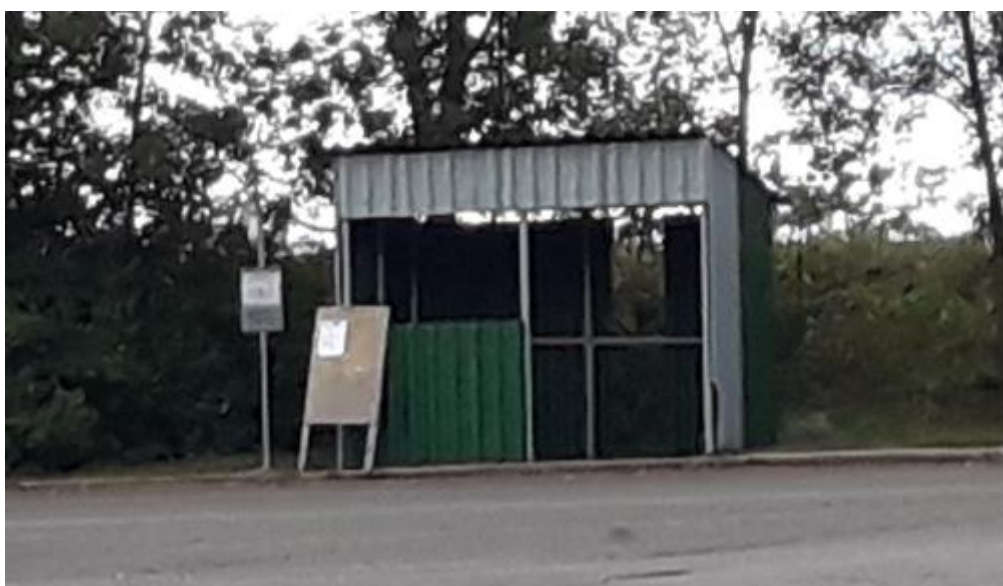
Autobusová zastávka „Zlonice – Tmář“.
