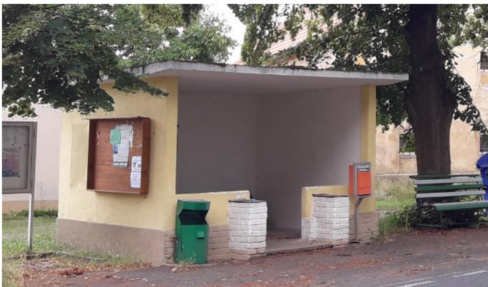
Autobusová zastávka „Zlonice – Vyšínec“.
