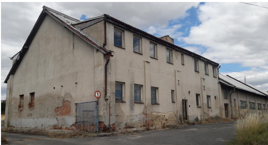
Zemědělský areál v severní části městyse Zlonice, který vyžaduje přestavbu.
