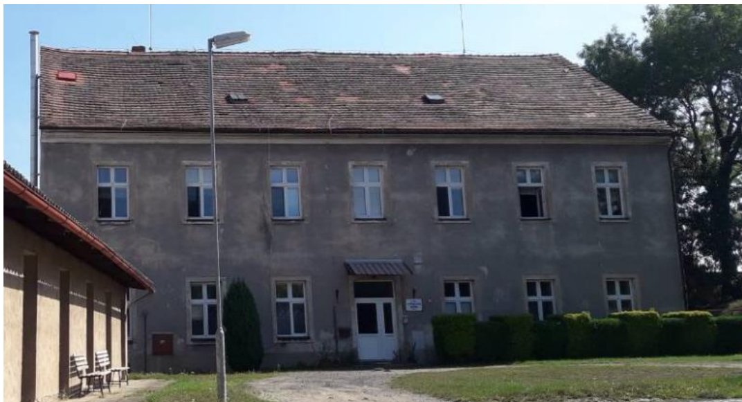
Dům s pečovatelskou službou ve východní části městyse Zlonice vyžadující rekonstrukci.
