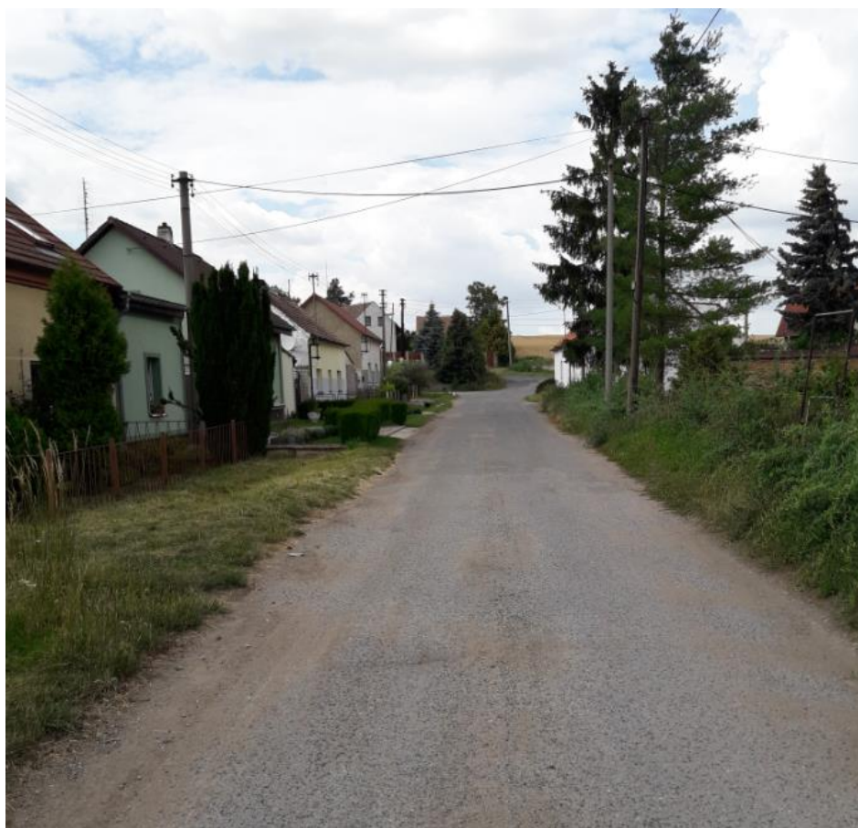
Místní komunikace ve Vyšínku – komunikace je zpevněná, avšak nedostatečné šířky.
