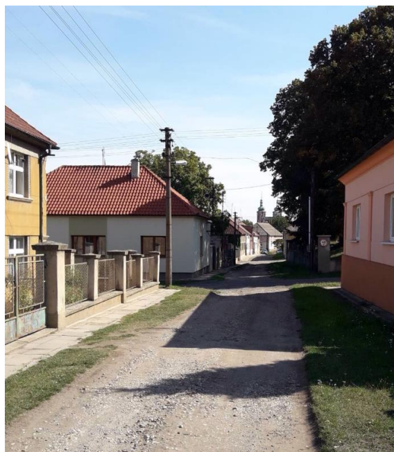
Nezpevněný povrch místních komunikací v západní části městyse Zlonice.
