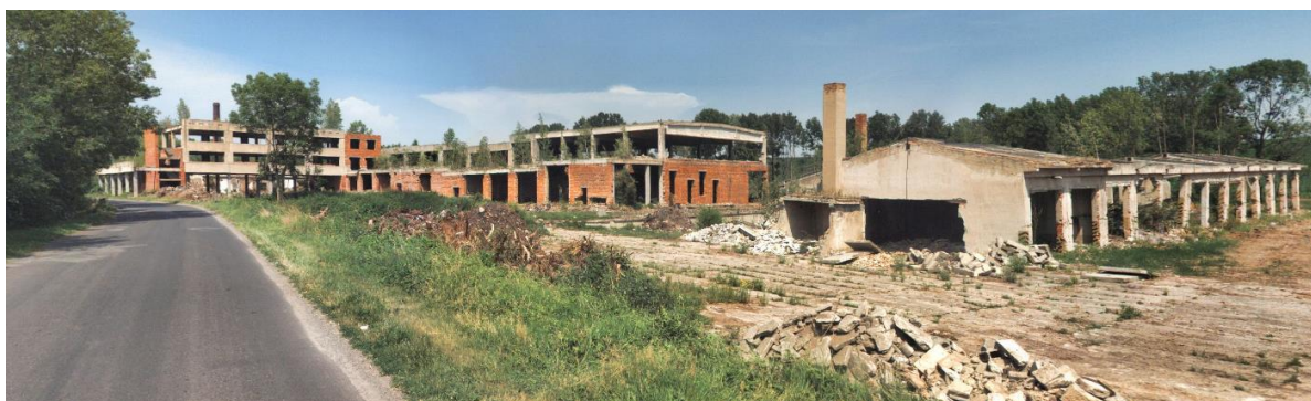
Zbořeniště nedostavěného zemědělského a administrativního areálu ve východní části městyse Zlonice, které vyžaduje přestavbu.
