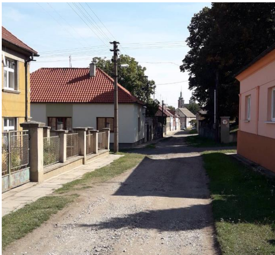
Místní komunikace v západní části Zlonic – komunikace je nezpevněná s nedostatečnou šířkou.
