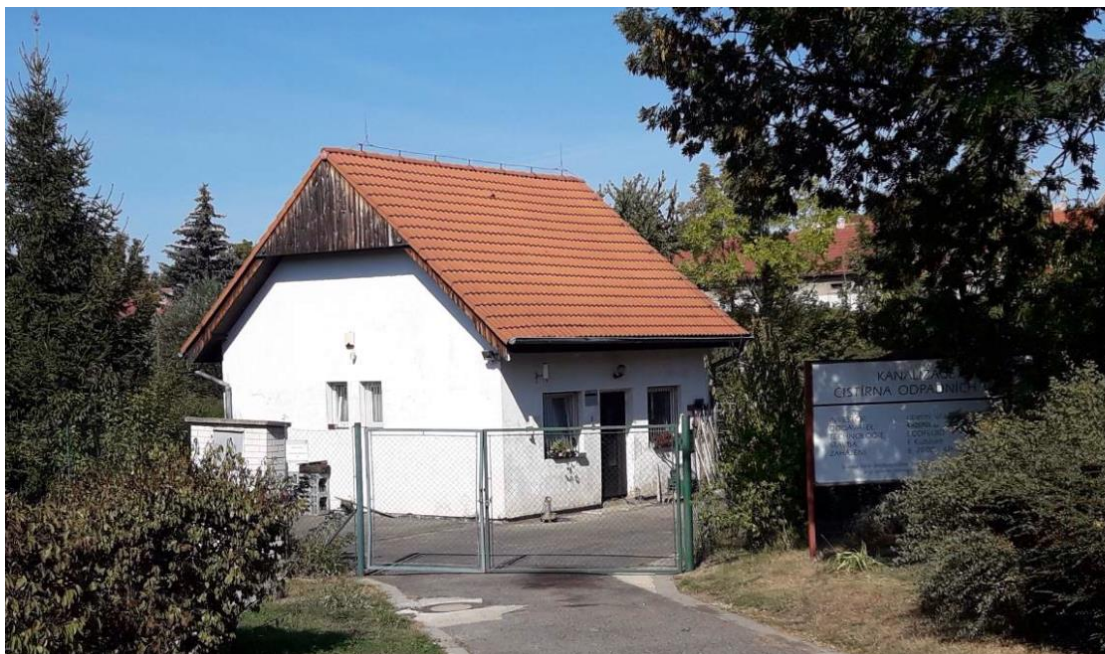
Čistírna odpadních vod ve východní části městyse Zlonice, která je vhodně lokalizovaná v údolí Zlonického potoka v rámci veřejné zeleně.
